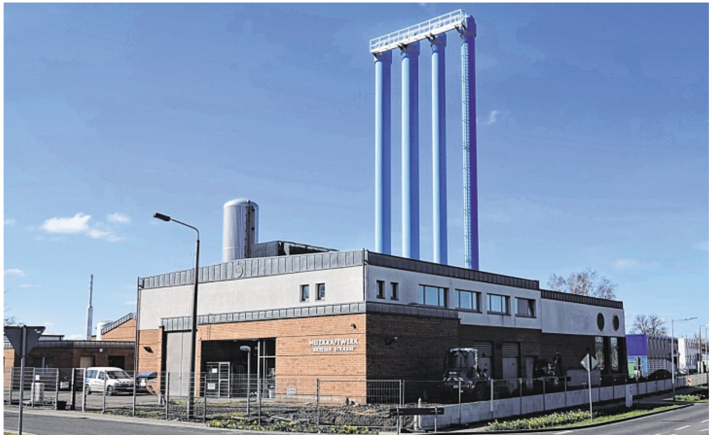
Im Heizkraftwerk Breeser Straße werden die Stadtwerke Wittenberge die Großwärmepumpe installieren.
