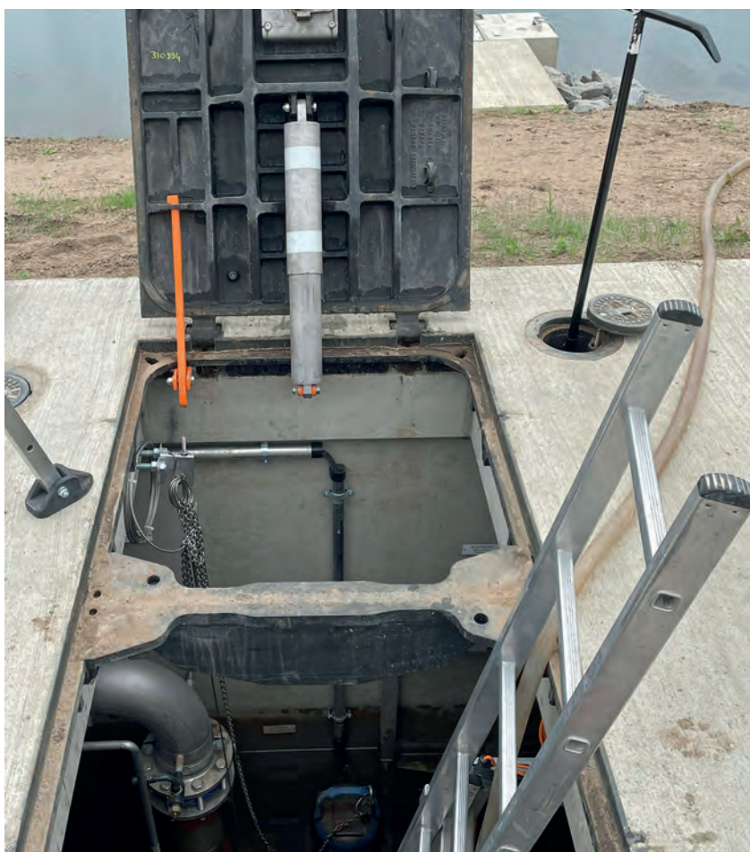
Bild 1. Im Bereich der Stepenitz wurde ein Entnahmebauwerk einschließlich Pumpenschacht errichtet
